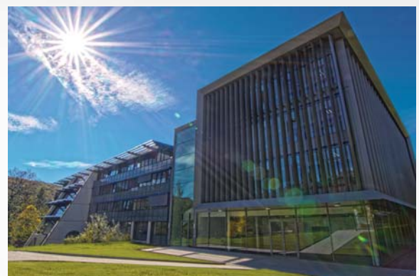
Bauabschnitt III, DFKI-Visualisierungszentrum
